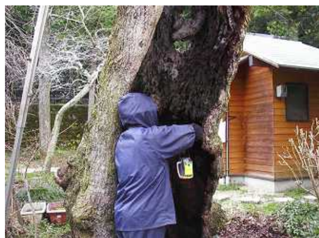
腐朽部をきれいにし表面に塗布
