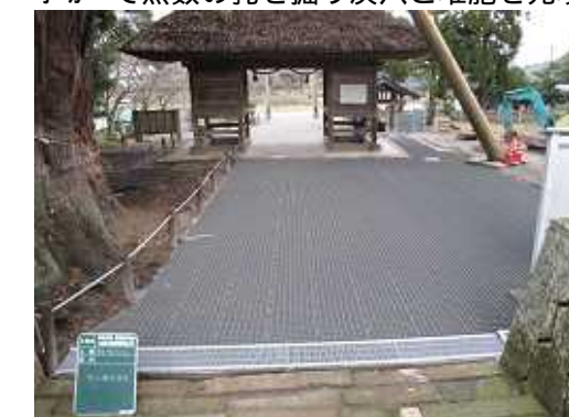
踏圧防止マット「砂利マット」敷設
