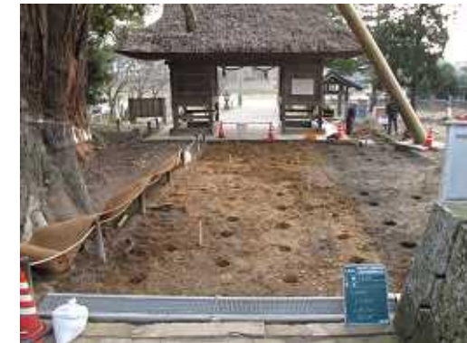
オガ-で無数の孔を掘り炭八と堆肥を充填
