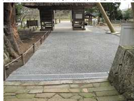
「砂利マット」に砂利を充填し完成
