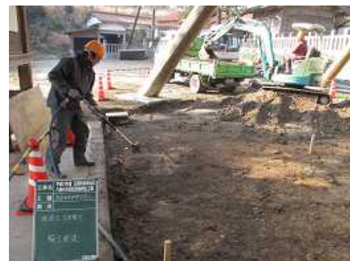
「Iア-スcoop」でのスキトリ作業
