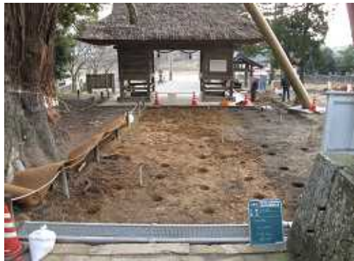
オガで無数の孔を掘り炭火と堆肥を充填
