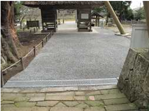
「砂利マット」に砂利を充填し完成
