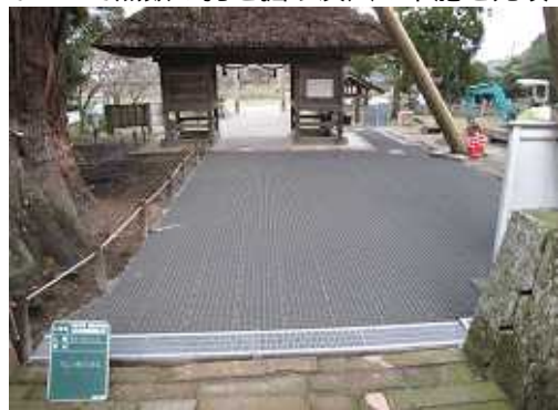
踏圧防止マット「砂利マット」敷設
