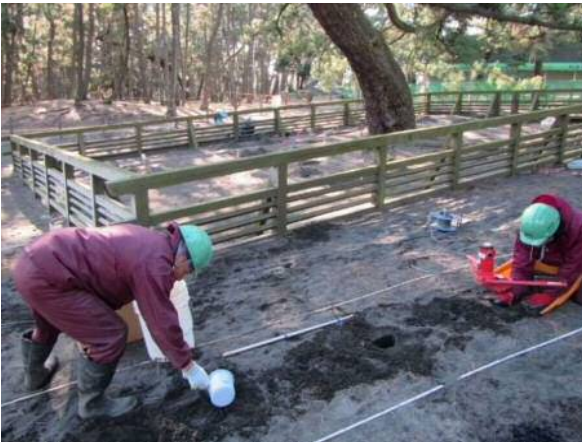
専用の機械での削孔 木炭充填作業
