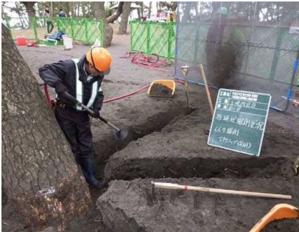
「エアースコップ」での床掘り作業（榎野）
