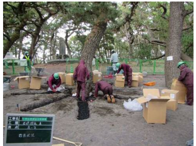
多孔質土壌改良用木炭「炭八」改良状況
