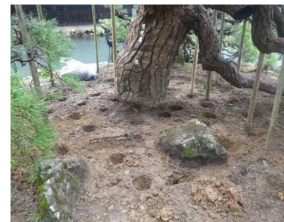
▲土壌改良 表土を剥ぎ取り、筒状に掘削
