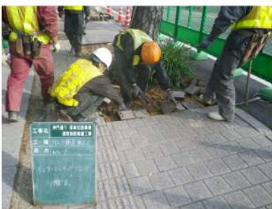
▲表層(インターロッキングブロック、アスファルト)を除去
