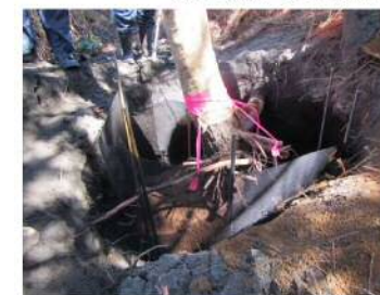
▲良質土に木炭を混合して埋戻し
