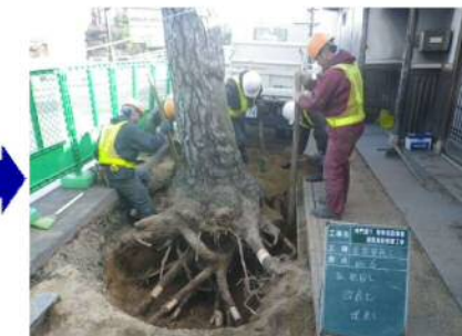
▲良質土(埴土+木炭)で埋戻し
