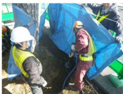
▲エアースコップ(圧縮空気掘削機)で床掘
